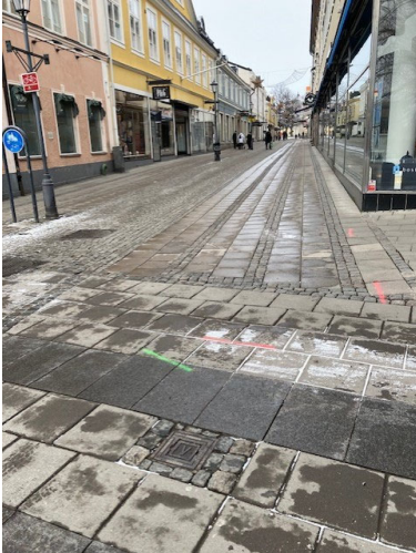
Bra snöröjd. Bra halkbekämpad (markvärme).
