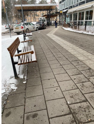
Bra snöröjd. Bra halkbekämpad (markvärme).
